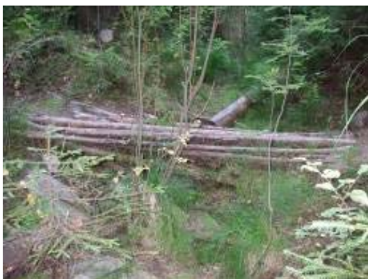
Puunrungoista tehty silta.
